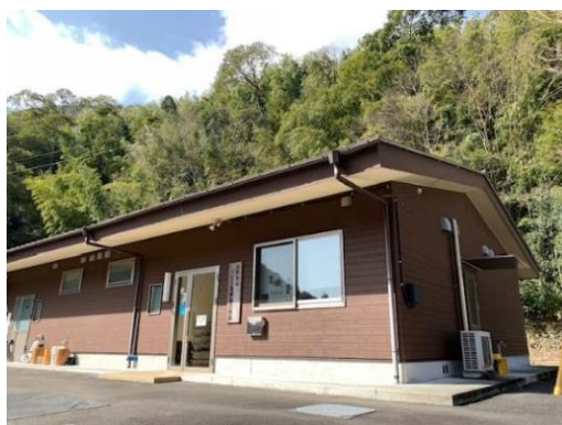
ジビエ処理加工施設
