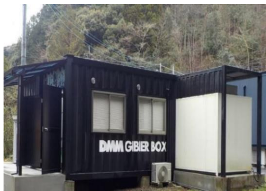
ジビエ処理加工施設
