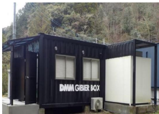
ジビエ処理加工施設
