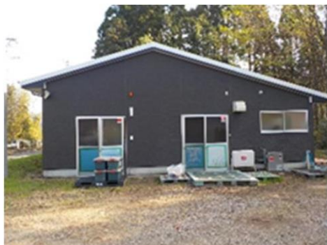
解体処理施設
