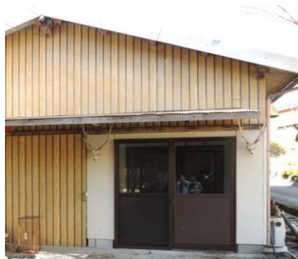
ジビエ処理加工施設
