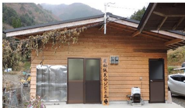
ジビエ処理加工施設
