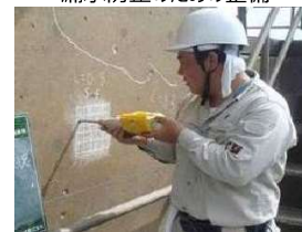
老朽化した施設の機能診断
