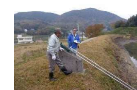
ため池の現地パトロール
