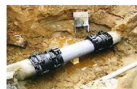
漏水防止のための整備
