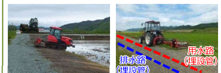
農機の旋回を容易にし、作業効率を向上させるターン農道の整備
