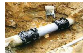
漏水防止のための整備
