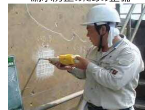
老朽化した施設の機能診断
