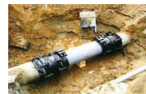
漏水防止のための整備
