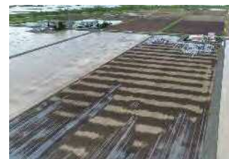
地下かんがいシステムの導入
