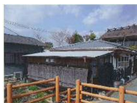
ハード改修施設 (改修前)
