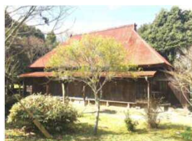
ハード改修施設:A棟 (改修前)
