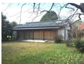
ハード改修施設:B棟 (改修前)
