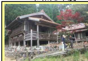
施設整備事業対象物件 旧矢岳駅駅長官舎及び 離れ
