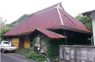
改修予定の古民家
