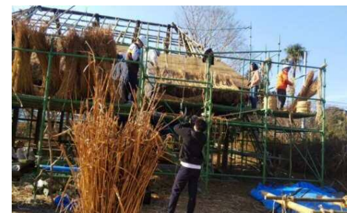
古民家再生体験教室
