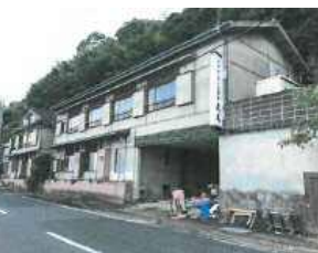
ハード改修施設 (改装前、外観)
