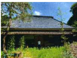
平川邸 (ハード改修施設)
