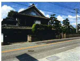
いそのさわ旧主屋 (ハード改修施設)
