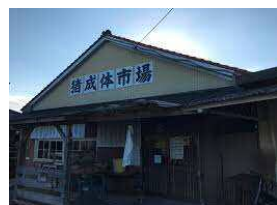
ハード改修施設 (改修前)
