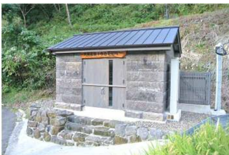
大日止昂小水力発電所
