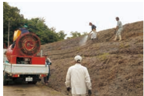
写真 4. センチピードグラス吹き付け作業
