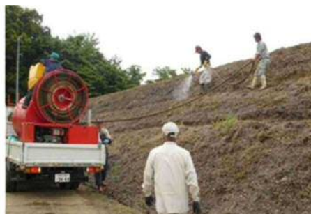
センチピードグラスの吹き付け
