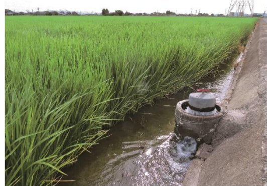
＜事業実施後＞ ほ場給水栓によるかん水
