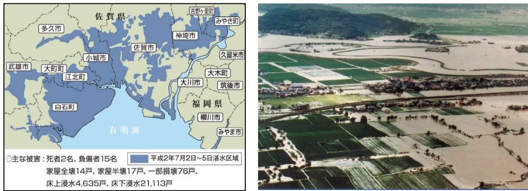
図 2-47 平成 2 年 7 月豪雨による湛水状況（左）と佐賀平野の湛水状況（右）
