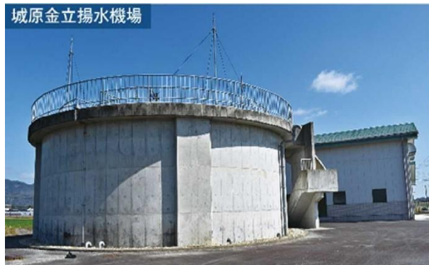
城原金立揚水機場
