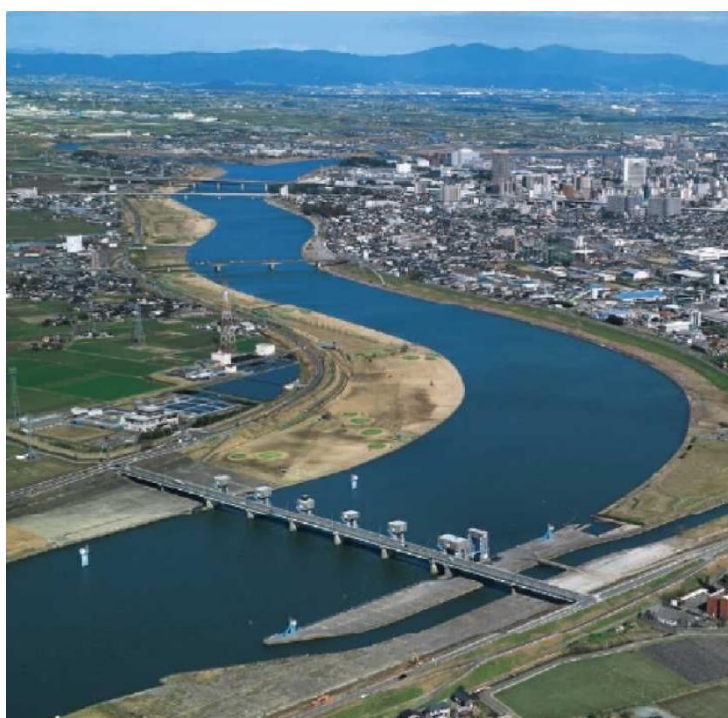
筑後大堰（筑後川）
