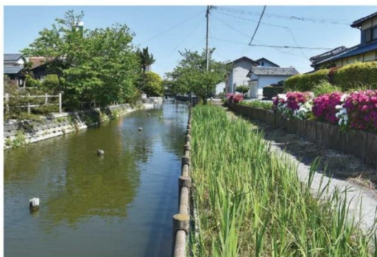
既存クリークを活用した親水公園の整備
