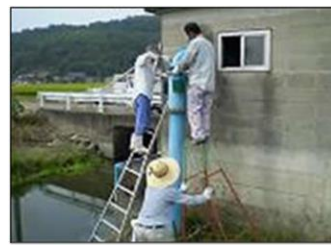
ポンプはき出し管の塗装
