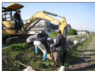
農道法面の瓦礫除去
