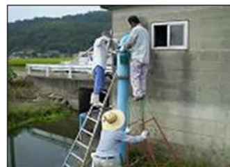
ポンプはき出し管の塗装
