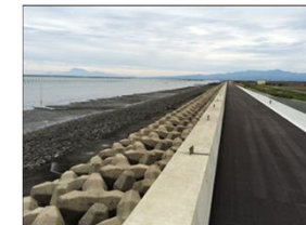
堤防の嵩上げ、堤体の補強等
