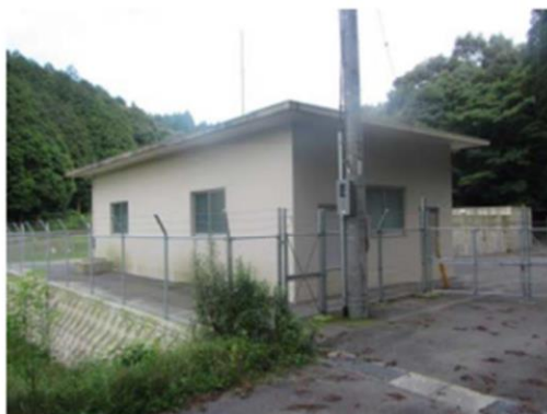
写真 5-6-3 大峯揚水機場(外観)
