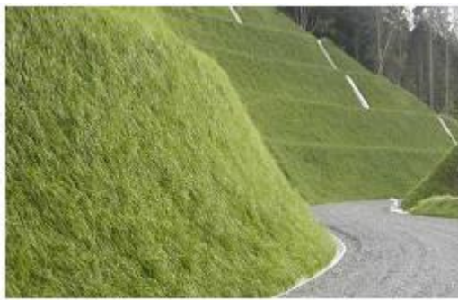
【付け替え道路法面の緑化】
