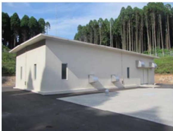
写真 5-6-1 金丸揚水機場(外観)
