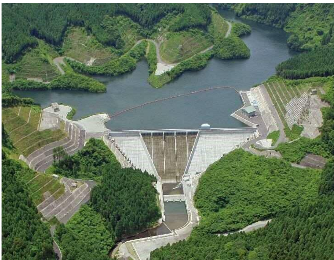
曾於市：谷川内ダム
