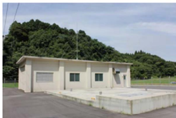
写真 5-6-7 外園揚水機場(外観)
