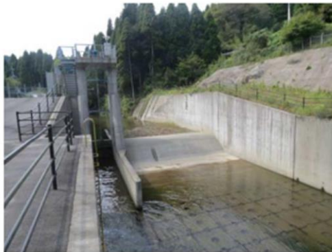
写真 5-3-1 頭首工全景(下流側)
