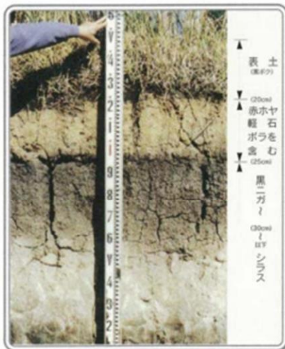
シラス台地の法面状況
