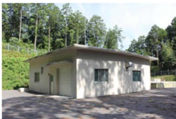
写真 5-6-5 高之峯揚水機場(外観)
