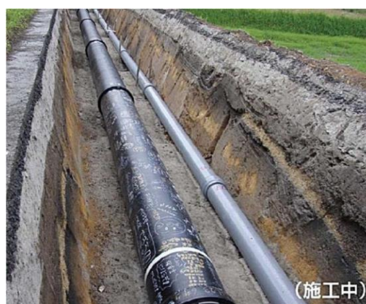
高之峯幹線配水路（左）及び 新原支線配水路（右）
