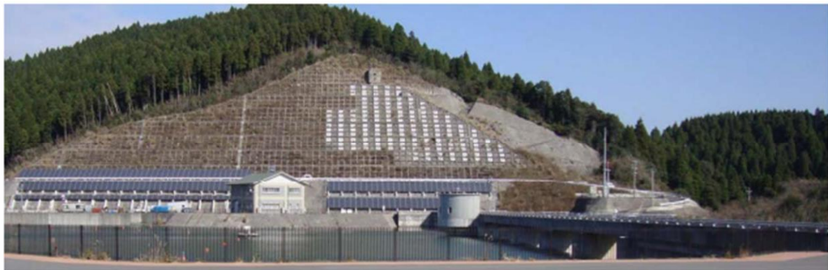
写真 5-9-2 太陽光パネル
