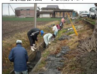
水路の泥上げ
