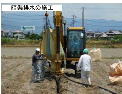
暗渠排水の施工
