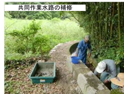
共同作業水路の補修
