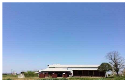
生活工房とうがらし建物全景
