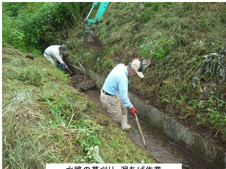
水路の草刈り、泥あげ作業
