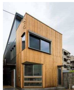
準防火地域内でのサーモ材外層仕上げ
