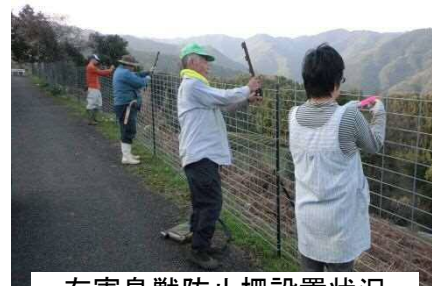
有害鳥獣防止柵設置状況
