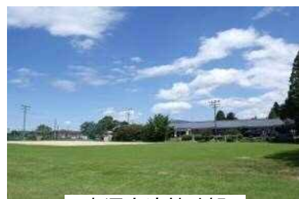
水源交流館外観
