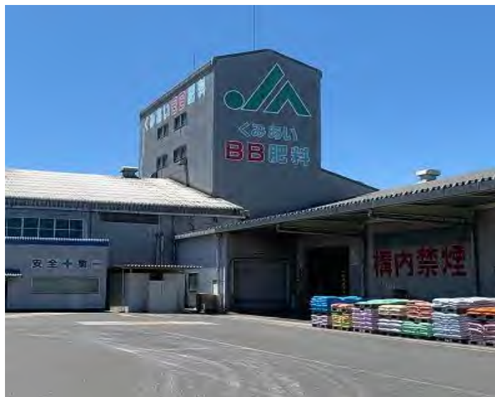
(株) JA物流かごしま 肥料工場
