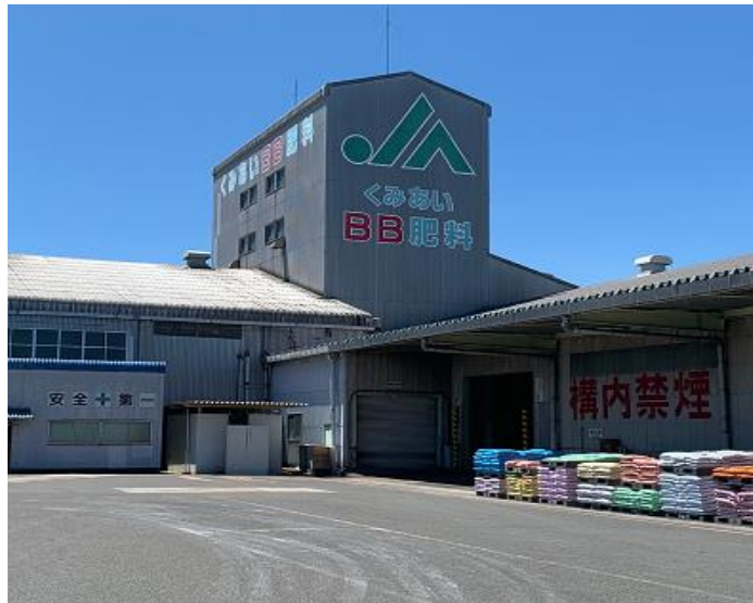
(株) JA物流かごしま 肥料工場
