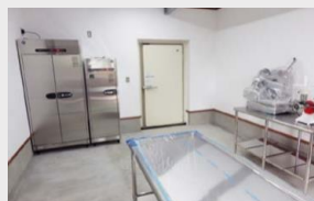
処理施設の内部
