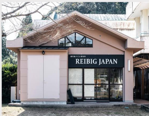
建屋（処理加工施設）
