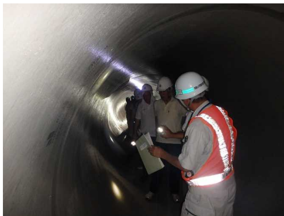
管路内での工事概要説明の様子
