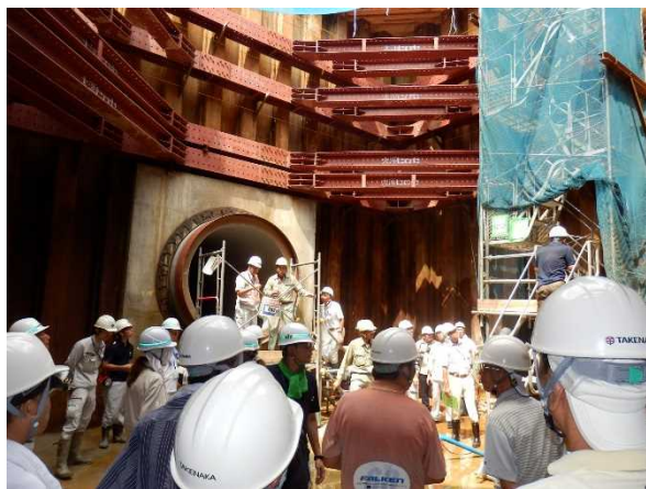
発進立坑内での見学会の様子
