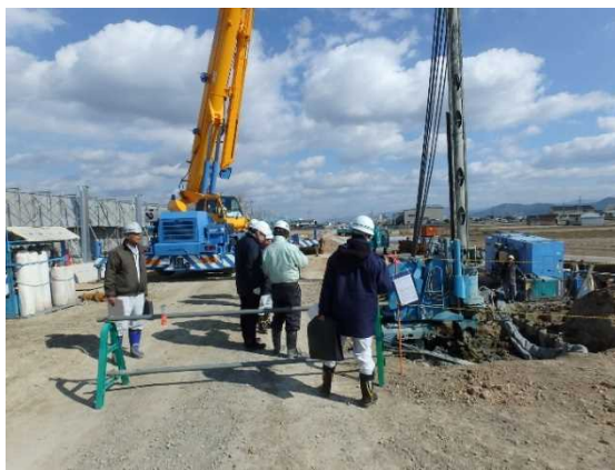
六箇井水路（高川排水路）
