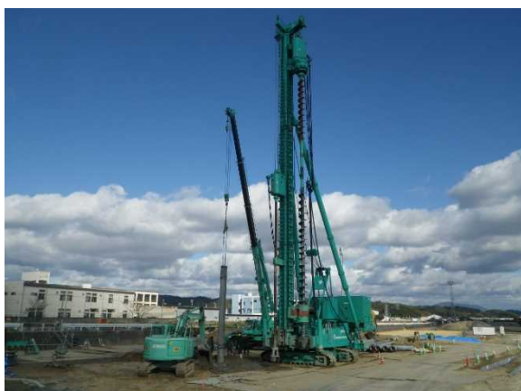
基礎杭の打設状況です。 (平成 29 年 1 月 16 日撮影)
