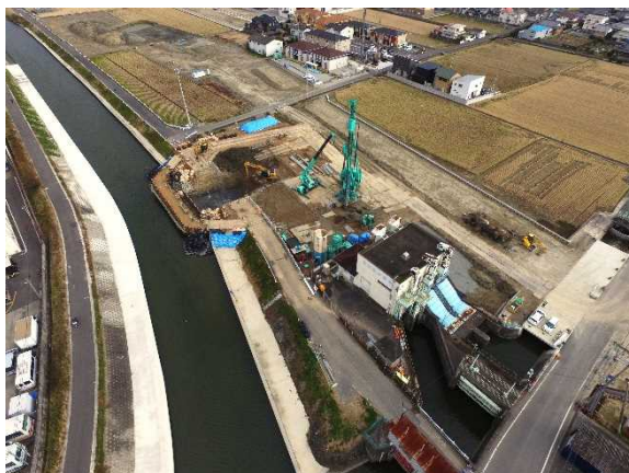
工事現場の全景です。 (平成 29 年 1 月 13 日撮影)
