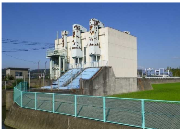
工事着手前の米田排水機場です。 隣に新しい排水機場を建設します。
