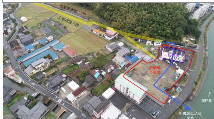
名草排水機場建設工事現場の様子 （ドローンによる空撮）
