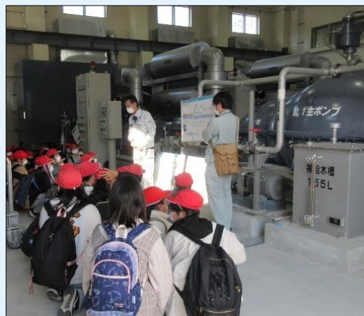
（排水機場の中で説明を受ける様子）
