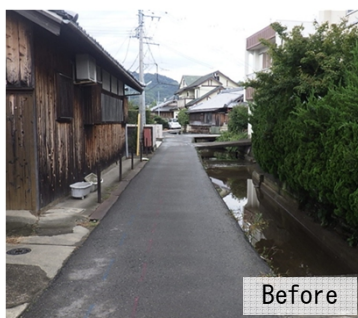
水路及び道路整備の状況
