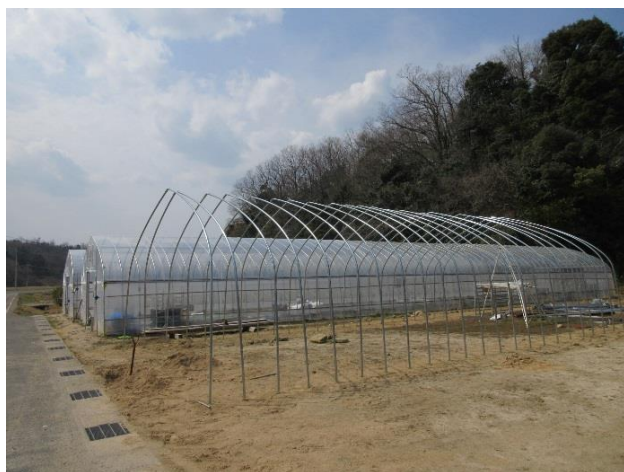
建設中のハウス
