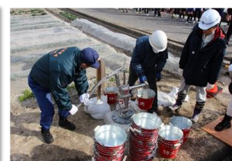
防災協力井戸の設置
