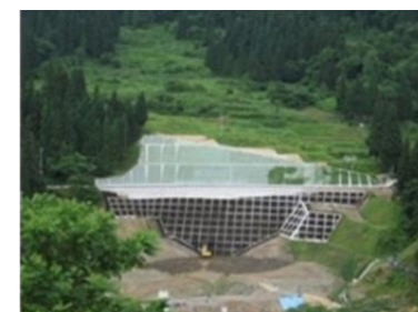
地すべり対策工事の完了
