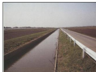
排水路の整備
