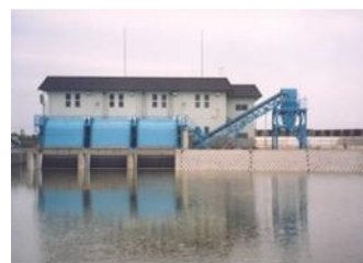
排水機場の整備
