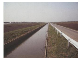
排水路の整備
