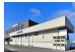
集出荷・貯蔵・加工施設の整備
