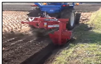
水田の排水条件の改善を支援
