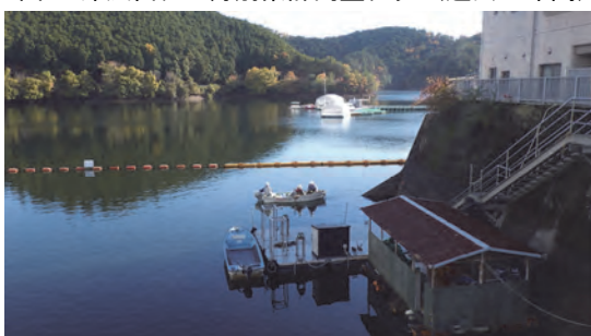
写真5 津風呂ダム係船設備状況(貯水率81%)
