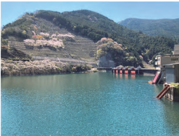
写真1 大迫ダム貯水状況(貯水率:約90%)
