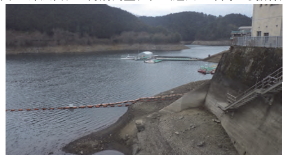
写真6 津風呂ダム係船設備状況(貯水率54%)
