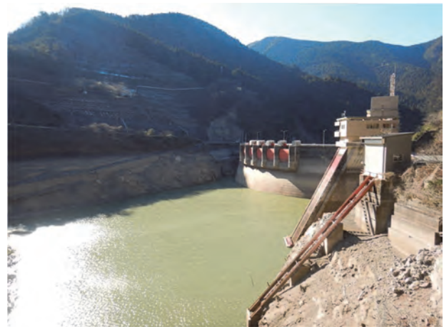
写真2 大迫ダム貯水状況(貯水率:約20%)
