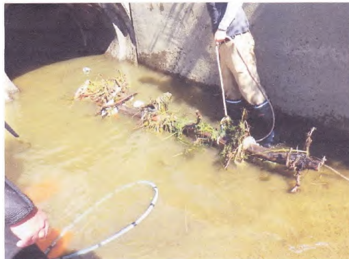
閉塞物の除去作業
