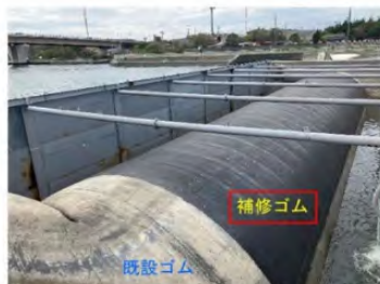
広い範囲を対象とした補修工法のイメージ
