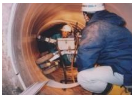
【管水路の調査点検・機能診断】
