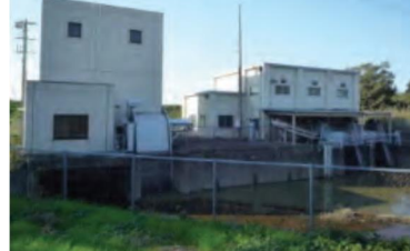
排水機場の監視・制御
