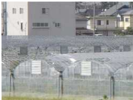
強風による農業用ハウス損壊 (和歌山県)
