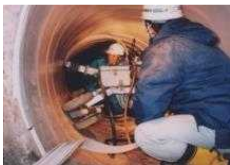
【管水路の調査点検・機能診断】
