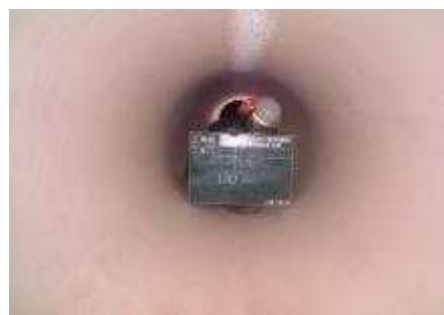
【管内面補修対策工】
