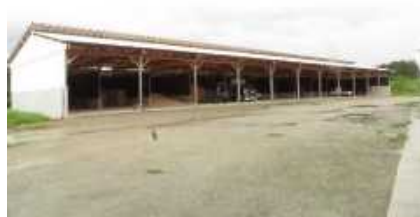
畜産クラスター事業で整備した堆肥舎
