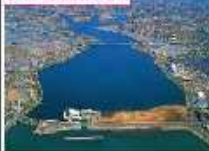
排水機場と周辺の市街地
