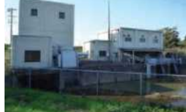
排水機場の監視・制御
