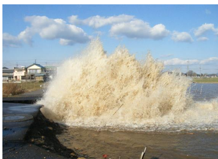
【管水路の突発事故（管の破裂）】
