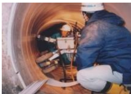
【管水路の調査点検・機能診断】
