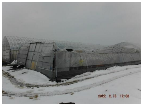
積雪によるビニールハウス倒壊(京都府)
