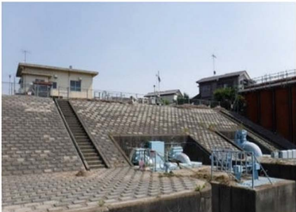
船玉揚水機場（河川側から撮影）
