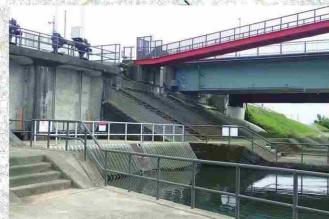
勝瓜頭首工(取水口)
