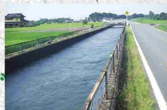
導水幹線水路
