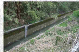
左岸幹線水路
