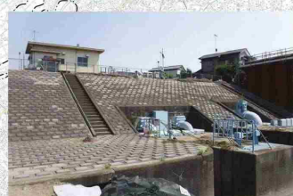
船玉揚水機場
