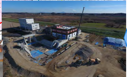
令和3年1月（遊水池ブロック積、底版打設）
