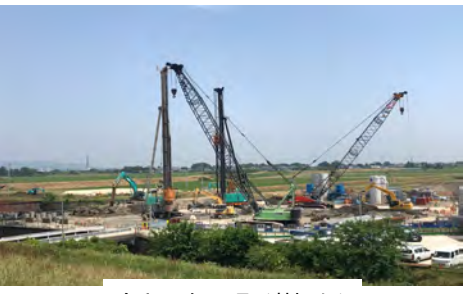
令和2年6月（杭打ち）
