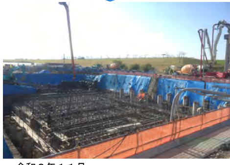
令和2年11月（吸込水槽本体部壁のコンクリート打設）
