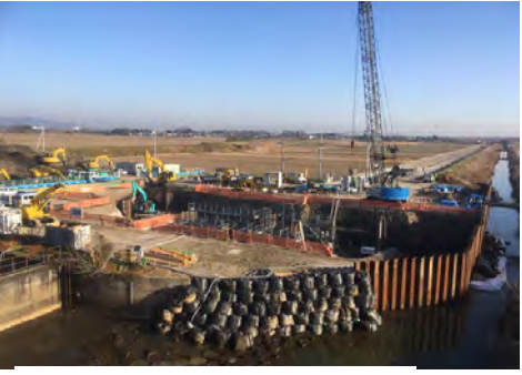
令和3年1月（西部自然排水樋門の底版鉄筋組立）
