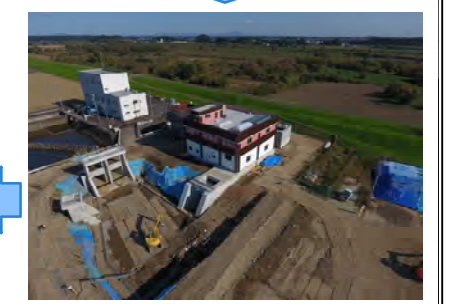
令和2年11月（遊水池造成、樋管上流部躯体のコンクリート打設）
