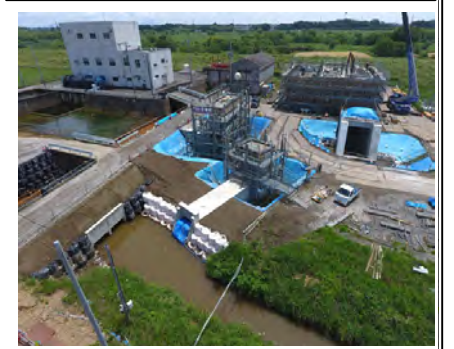
令和2年6月（建屋躯体型枠締固め、制水門躯体のコンクリート打設）
