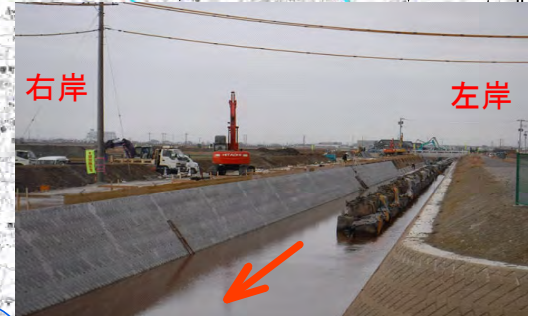
新荒川排水路改修その10工事のブロック積工（左岸側は昨年施工済、右岸側は今年度施工）
