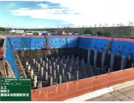
令和2年9月（機場本体部掘削）
